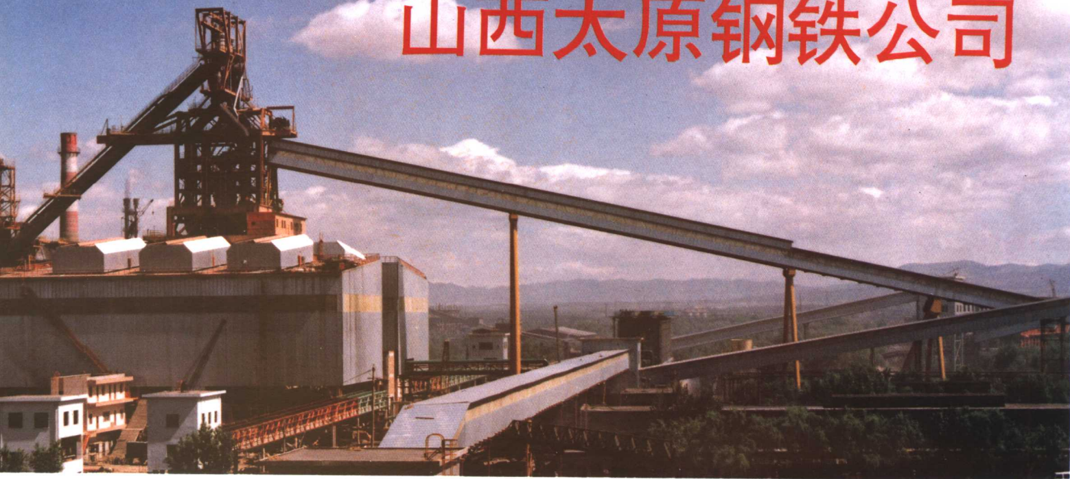
新建成的 1350m 3 高炉
