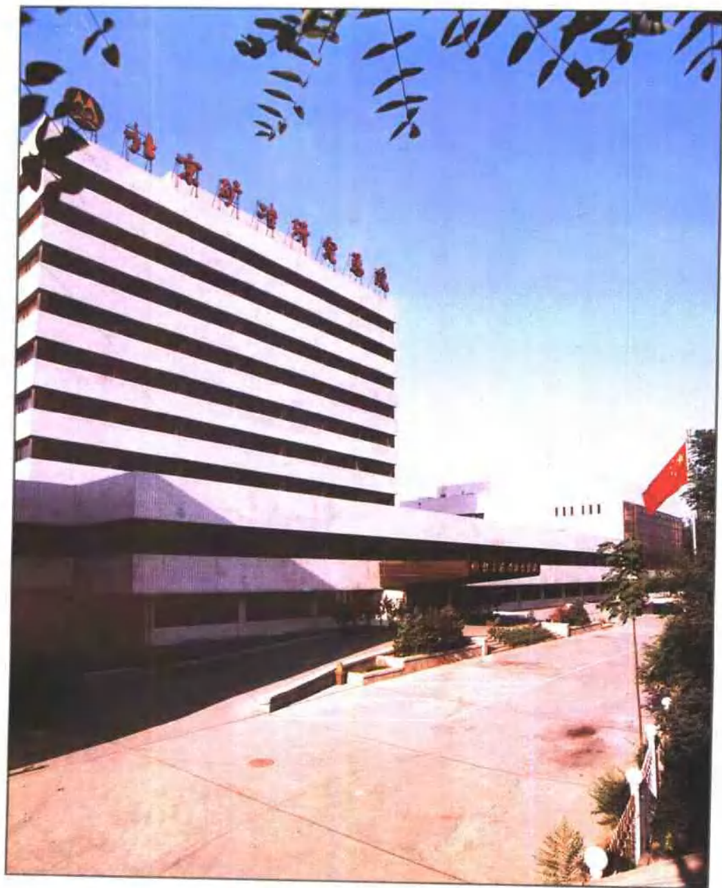
▲ 北京矿冶研究总院院部主楼
