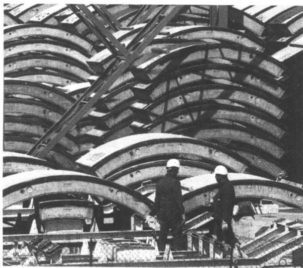
图 1-1 建造运河隧道所用的混凝土构件堆积的现场。任何一种建筑物必须拥有一定的量的物质基础。
