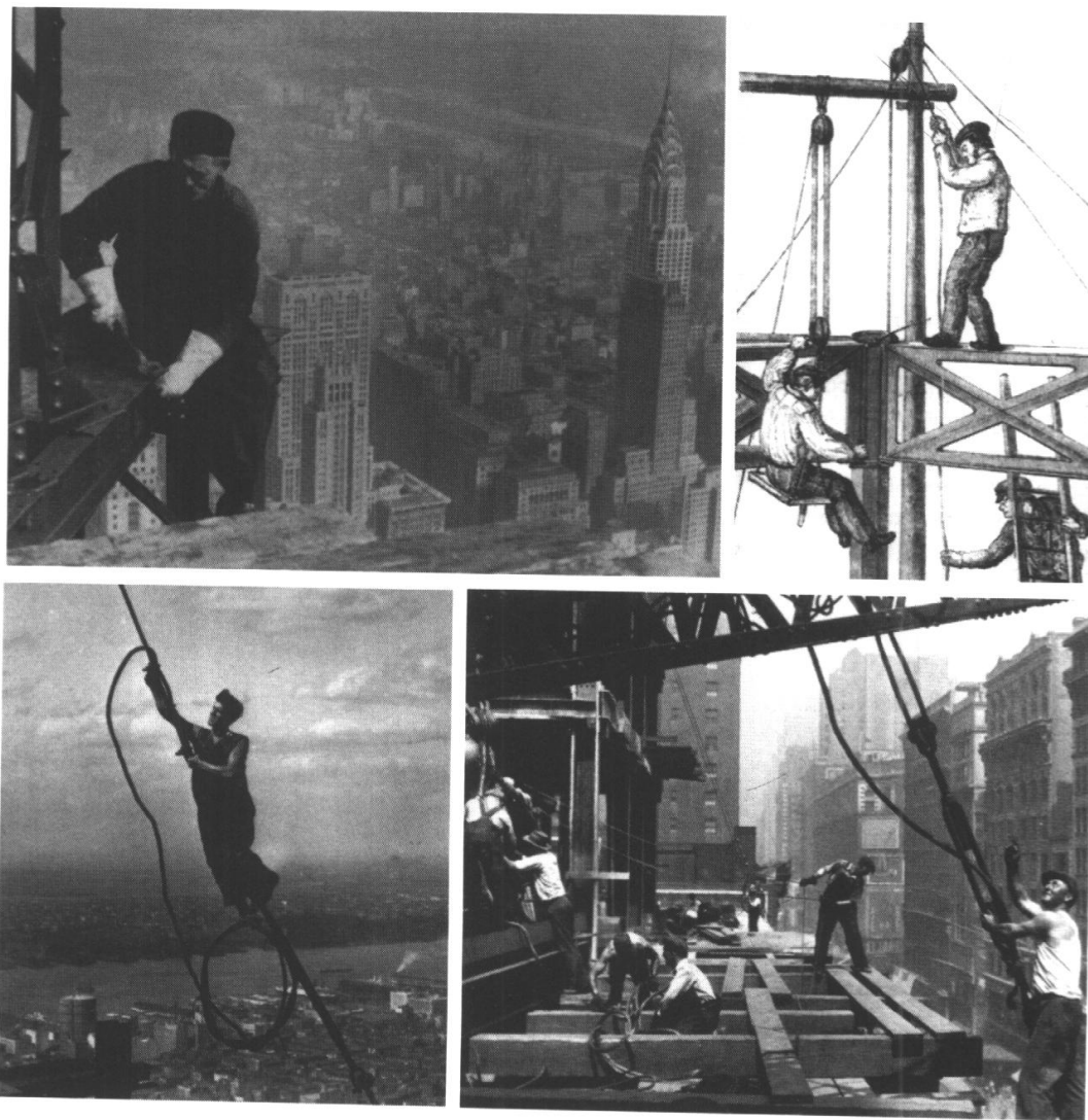
图 1-10 本世纪 30 年代建造帝国大厦的技术工人工作的场景。建造摩天大楼如在中世纪可能要几百年的时间，而在本世纪初随着建造技术的更新和工人素质的提高，工期大大缩短了。
