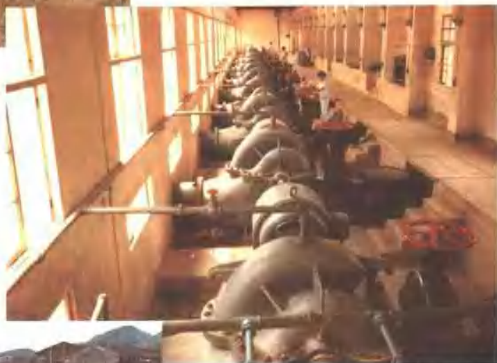
潘山翻水站泵房
