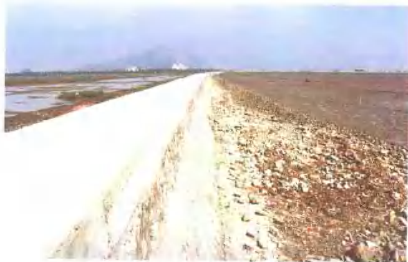
丁山一期围垦主堤坝
