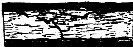
图 1-2 含钢率很大的梁的破损情形
