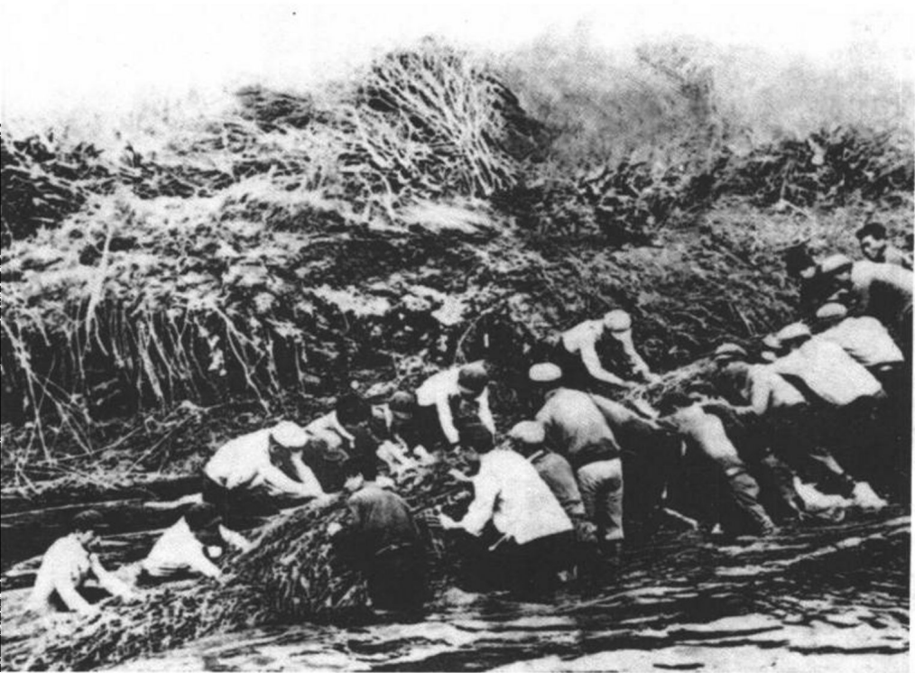
▲“五·七”干校学员在修筑拦河堤坝。
