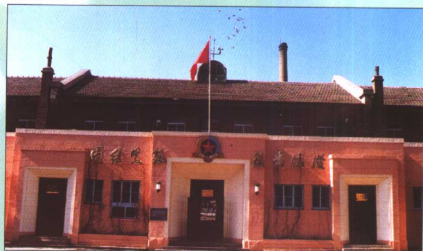
沈阳市第一二四中学教学楼
