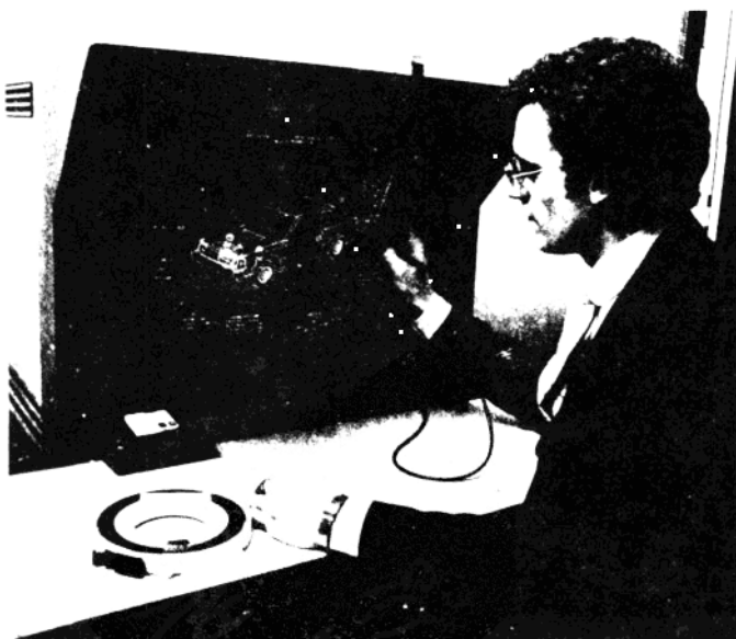
圖 1-1 利用交談式繪圖設備，作小客車某部分變更設計。
