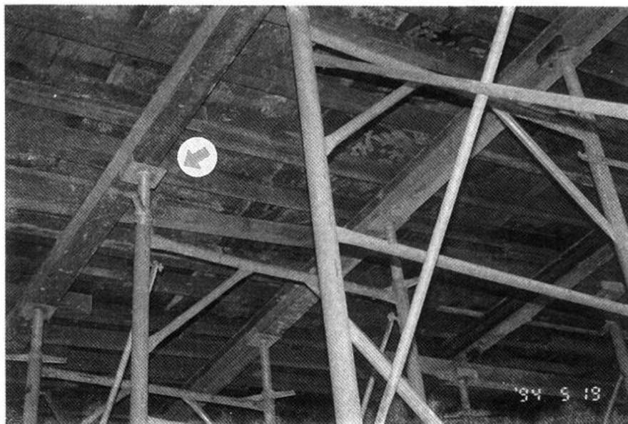
相片三 大格柵正確組立方式
