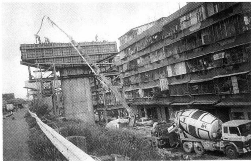
相片八 高速公路拓寬工程橋墩採用四層模，確保強度及勁度
