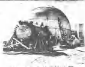
正欲運入圍阻系統的反應器容器
