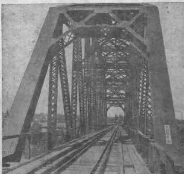
影片 VII 穿越式桁架橋
