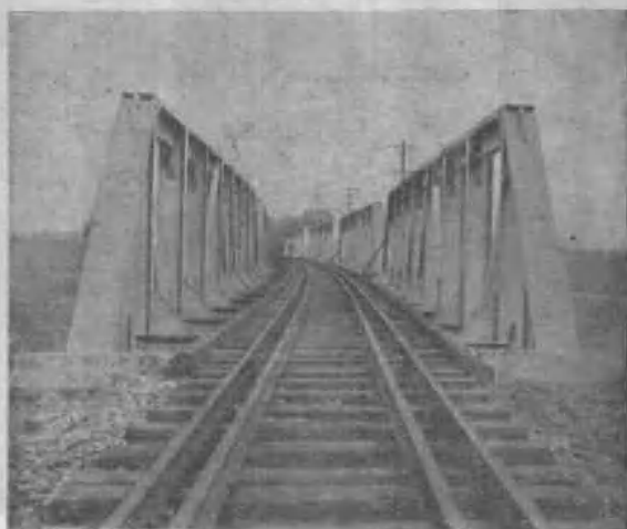
影片 VIII 橋桁架橋(軌道係曲線)
