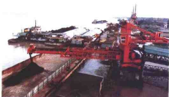
芜湖港裕溪口煤码头
