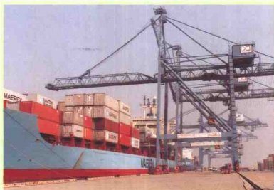
作业中的岸吊
