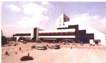
芜湖港客运站站前广场
