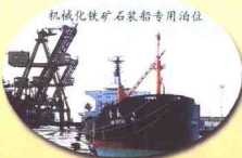
机械化铁矿石装卸专用泊位
