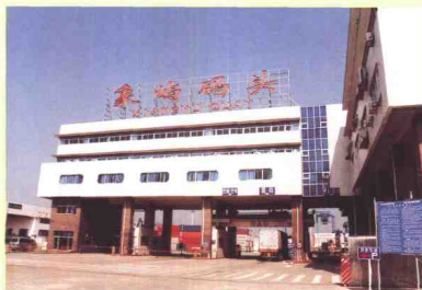
闸口及行政大楼
