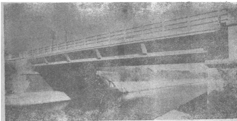
图 1 佛罗利得預应力混凝土桥
