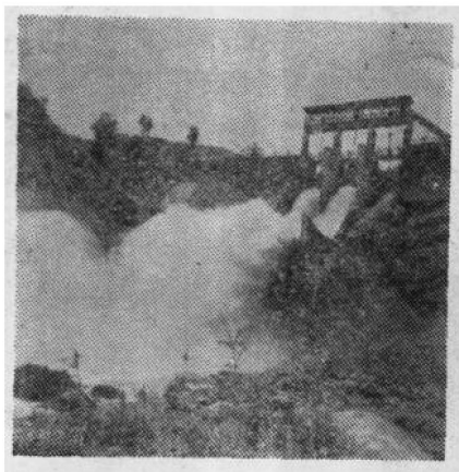
湖南省王家湾水库溢洪道
