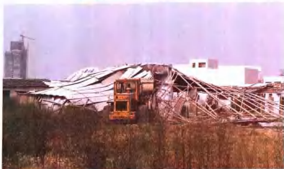
拆除违章棚屋
