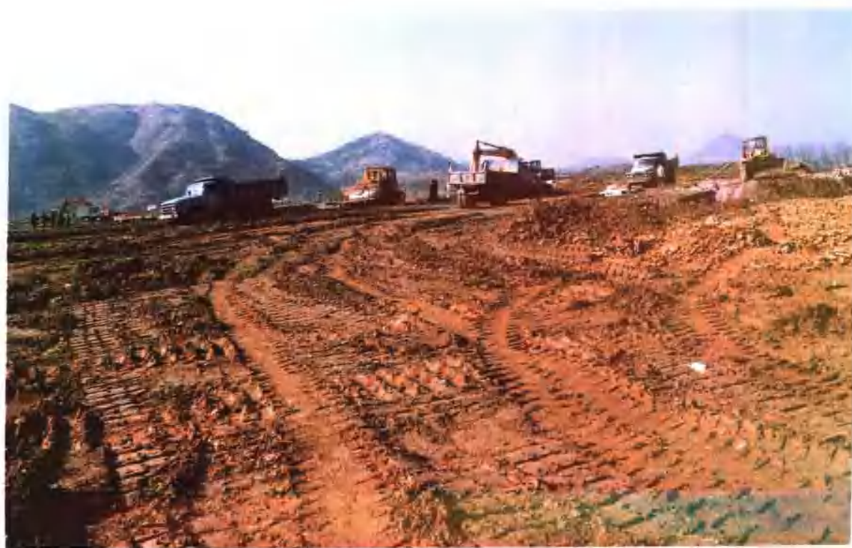
施工现场一角
