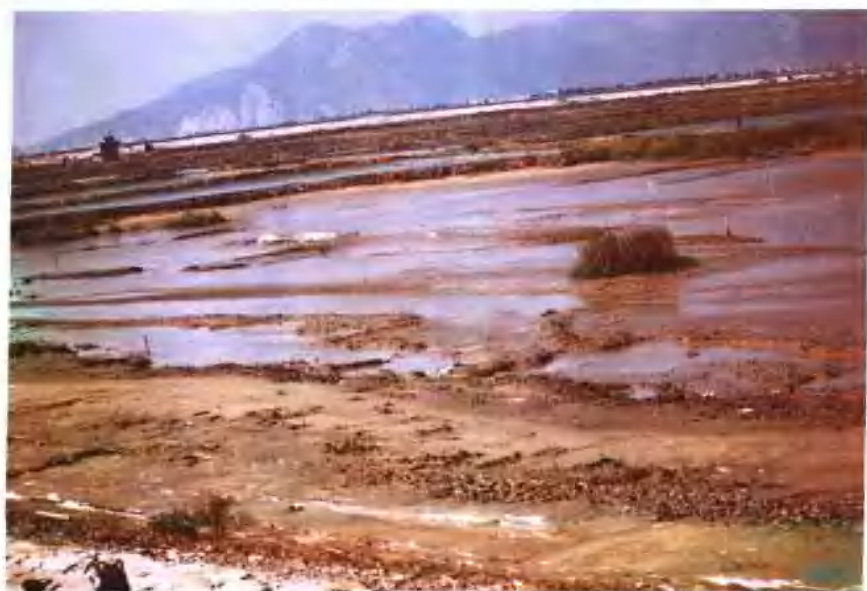
瓯海水兴围涂工程
