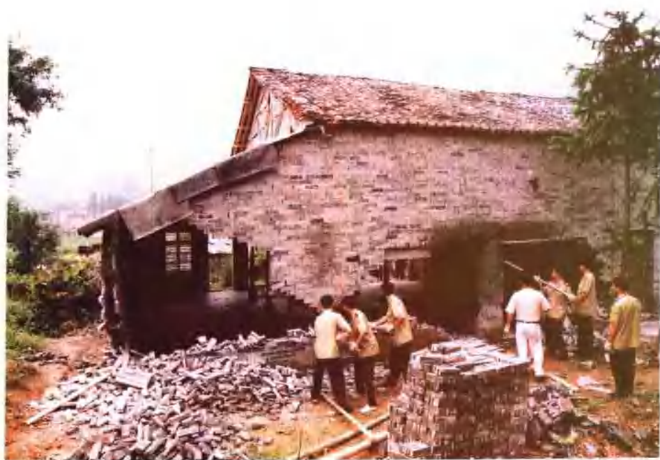
拆除违章建房
