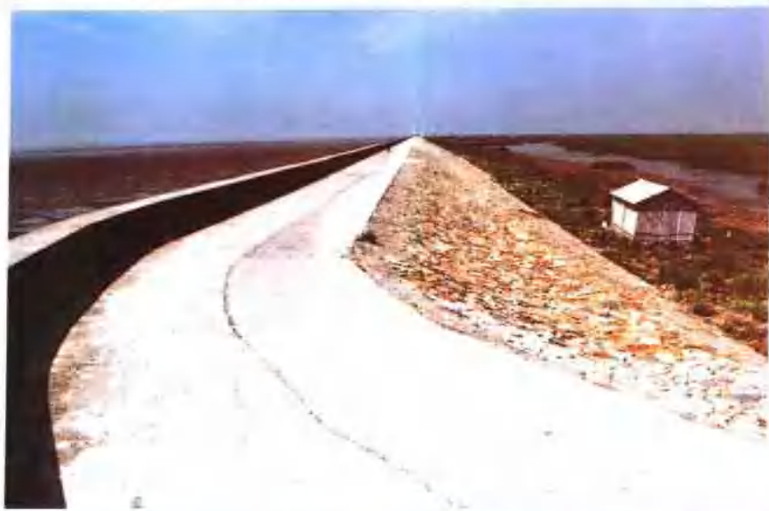
瑞安丁山促淤一期(梅头)围垦工程
