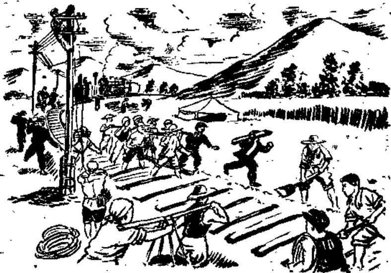
图1 “解放军打到哪里，铁路就修到哪里”这是抢修队伍在架电线、修铁路的情景。
