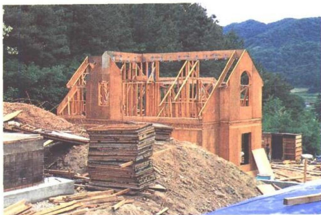
4. 2层墙构架工程
