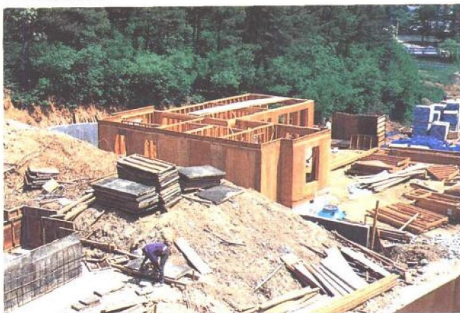
3. 1层墙构架工程
