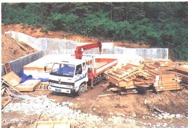
2. 基础及地面工程
