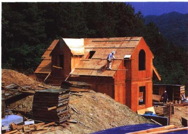
5. 屋顶构架工程
