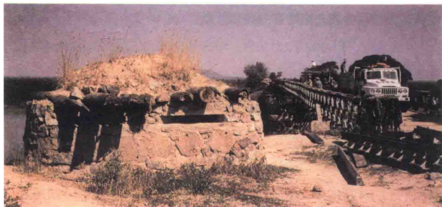
施工现场到处可见交战各方修筑的工事
