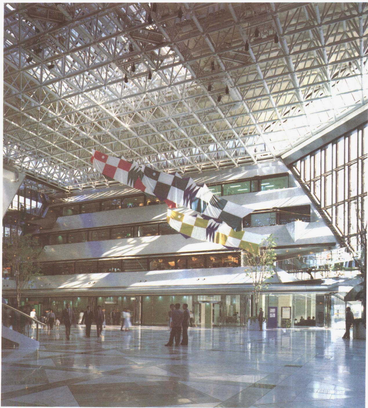
高大空间内，钢结构天棚与内部设计有机地结合起来
