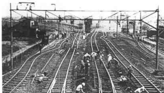
↑ ⑲ 日本新潟地震时的轨道受损
