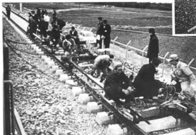
↑ ⑳ 日本鸭宫试验线经压屈 试验后轨道
