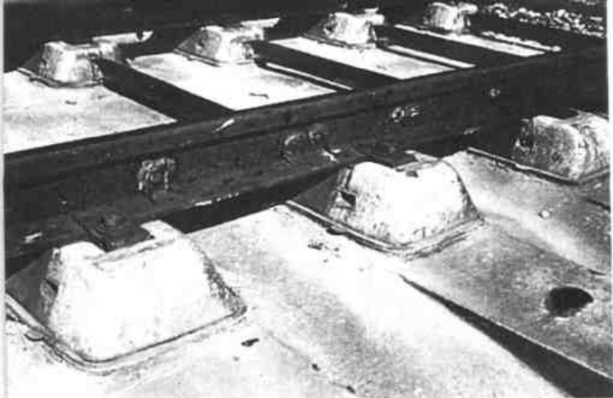
← ④ 法国的弹性支座 直接联结轨道
