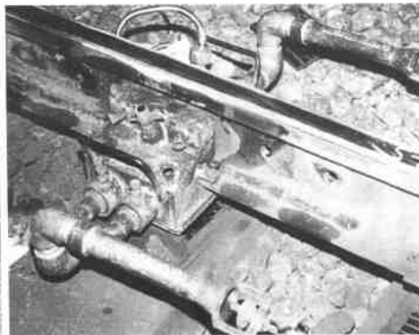
↑⑥⑫ 钢轨热弯曲 — 松开钢轨扣件并在底部加热
