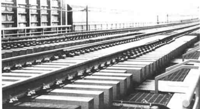
→ ㉒ 日本的桥上伸缩接头——铺设于合成轨枕上。
