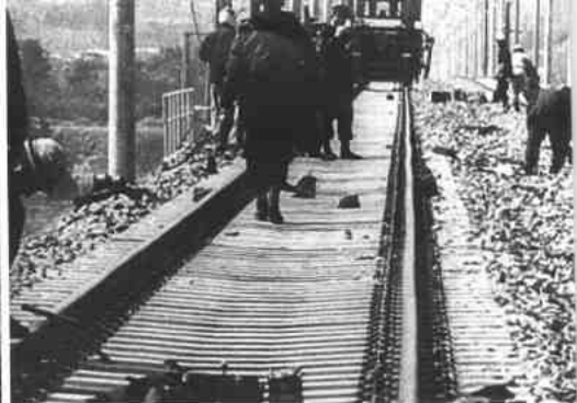
↑ ⑱ 1963年在日本鸭宫试 验线上实施的时速为 247km/h蛇行试验中 所发生的轨道横向移 动
