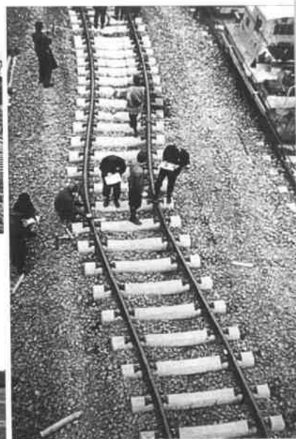
↑ ⑳ 日本鸭宫试验线经压屈 试验后轨道
