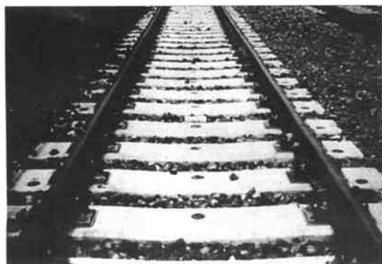
↑ ⑩ 铺设完成后弹性轨枕直接联结轨道
