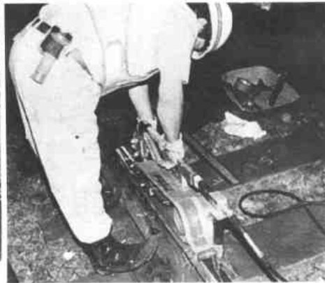
↑⑥⑭ 钢轨热弯曲— 打磨
