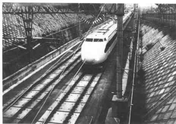
← ②土路基上的轨道板
