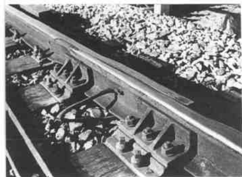
↑ ㉕ 法国的一般区间用伸缩接头
