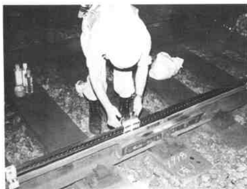
↑⑥⑪ 钢轨热弯曲 — 钢轨头顶面凹凸的测定
