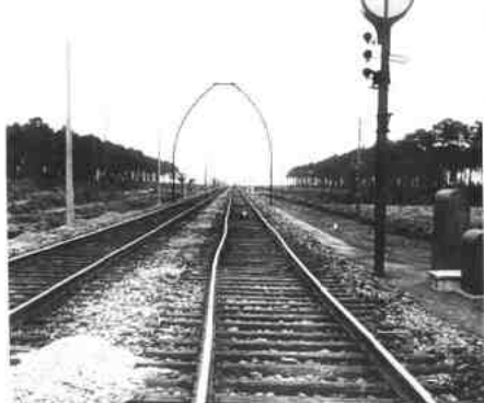
↑ ⑰ 1955年法国列车以 331km/h的速度运 行时所发生轨道横 向移动
