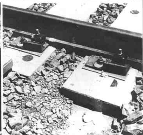
↑ ⑨ 弹性轨枕直接联结轨道的铺设
