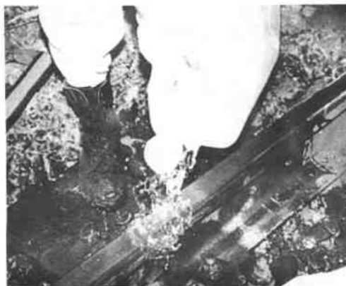
↑⑥⑬ 钢轨热弯曲— 用水冷却
