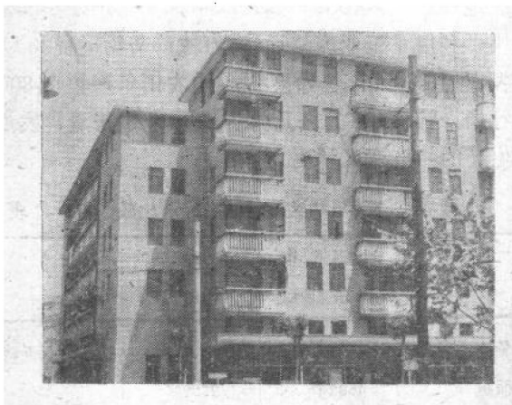
图 1-2 用蒸养煤渣砖建造的楼房
