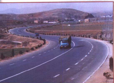
▲ 312 国道南阳段文明样板路
