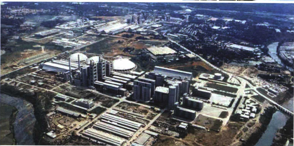
印尼水泥第六、七、八號生產線。六號窯德國機器，七、八號窯法國機器，各年產150萬噸（1984—1986）。遠處為一至五號窯及紙袋工場廠區。
