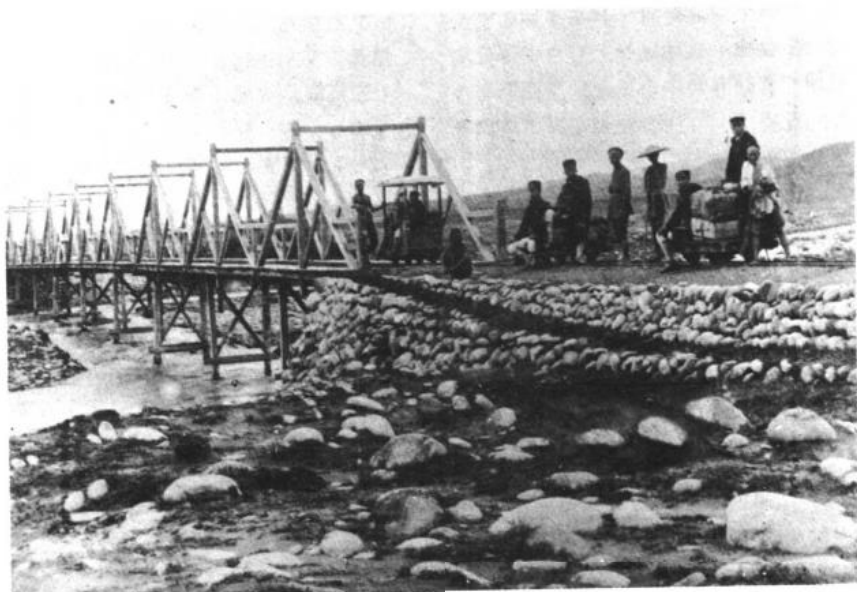
上 / 此圖為昔日架設大甲溪上的台車便道。
