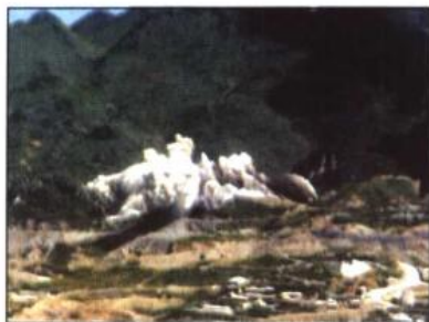
4-2 溢洪道2号山体削顶大爆破，药室全部起爆。总装药量232t，爆后形成平台进行深孔台阶爆破
