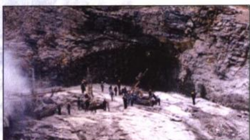
2-1 水平预裂是坝基快速开挖的重要组成部分，图为水平预裂与垂直预裂、斜面预裂爆破后的建基面
