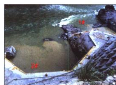
5-6 爆破拆除后的状况
