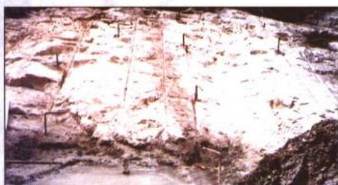
2-2 水平预裂爆破后的建基面
