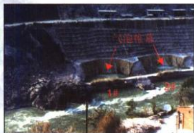
5-1 平台上方平房为闸门启闭机房
