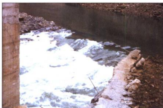
2-5 导流洞进口岩坎及混凝土围堰爆破拆除后的过流情况，爆后过流断面未做任何处理
