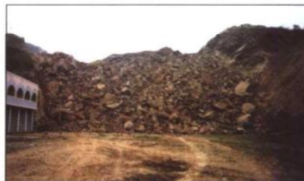
10-6 开州大道东头爆破后状况，爆堆前沿距二层楼房3~4m
