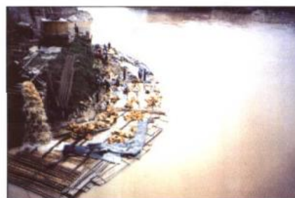
7-4 围堰爆破的防护
