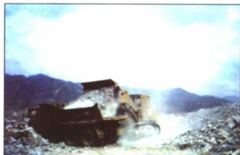
4-7 过渡料正在装运上坝
