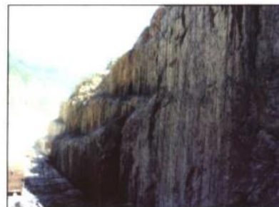
4-5 溢洪道右边墙预裂后的壁面，台阶高度22m
