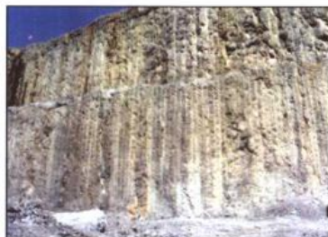
4-4 溢洪道左边墙局部预裂壁面
