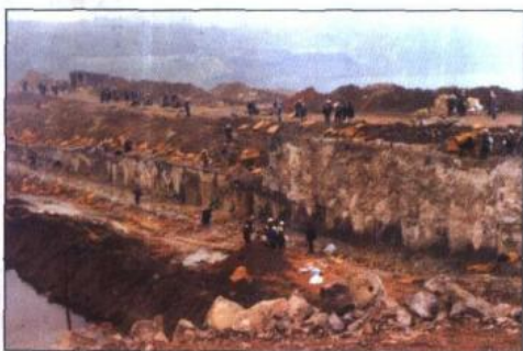
1-1 大江围堰两道混凝土防渗心墙爆破拆除前全景
