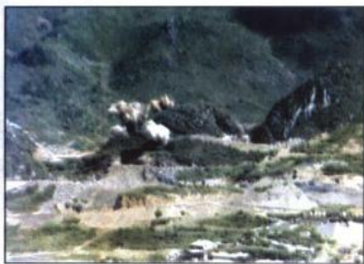
4-1 溢洪道2号山体削顶大爆破，部分药室已经起爆
