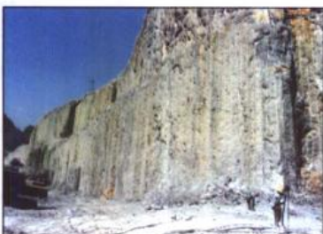
4-3 溢洪道左边墙预裂壁面，台阶高度22m
