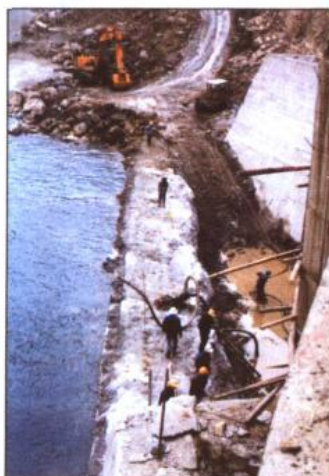
2-6 导流洞出口岩坎及混凝土围堰爆破前
