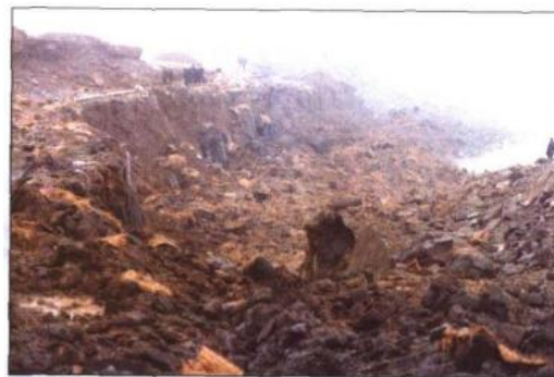
1-4 混凝土防渗心墙炸除后的情景
