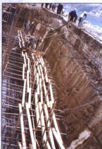
2-4 导流洞进口岩坎及混凝土围堰爆破前
