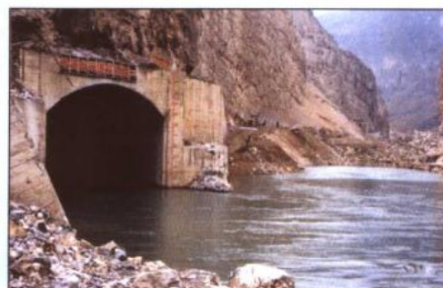
2-7 导流洞出口岩坎及混凝土围堰爆破拆除后的过流情况，爆后过流断面未做任何处理
