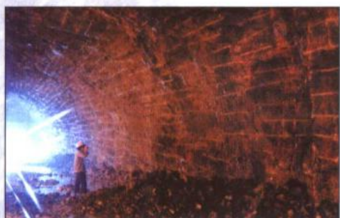
2-3 地下厂房光面爆破后的整齐基岩面
