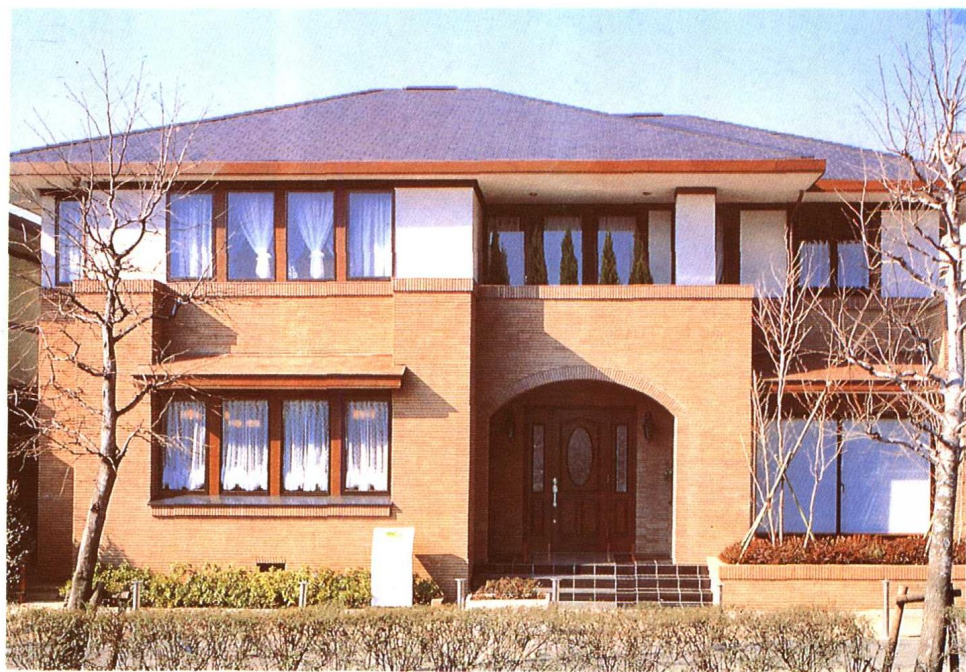
1.外观。二种配色的外墙和黑色的房顶形成美观的格调，四坡顶式安定感的构造，稳重的缘饰、瓷砖的外墙等，可见其混然一体的风格。
