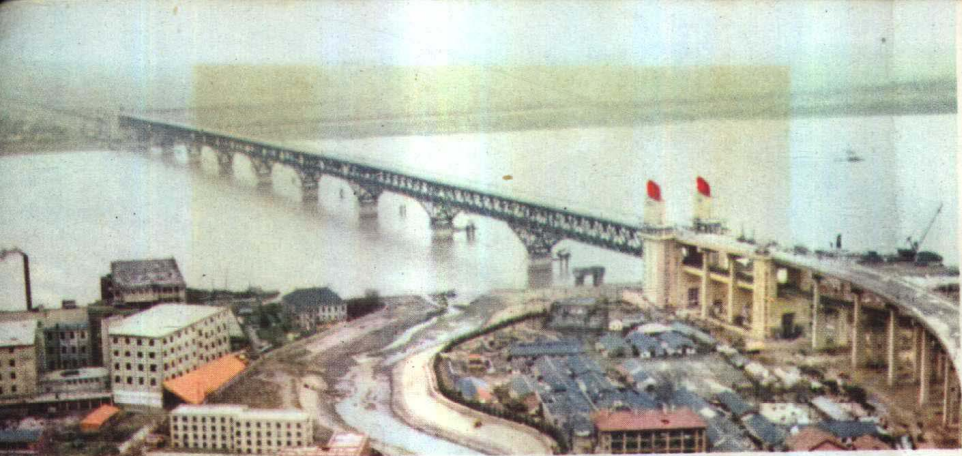
⑦ 南京长江大桥
