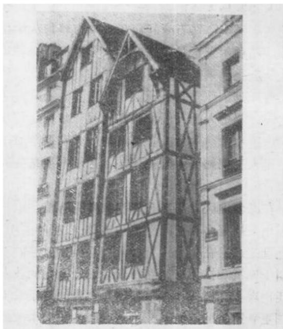
图 1-2 熟石膏灰浆用做木结构房屋的抹面
