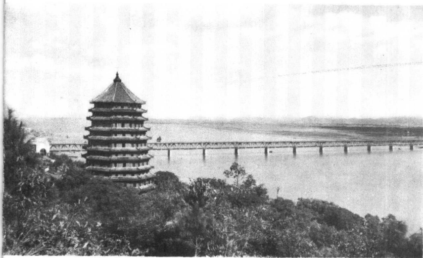
1937年9月26日，茅以升主持设计建造成中国第一座铁路、公路现代化大桥——钱塘江大桥
