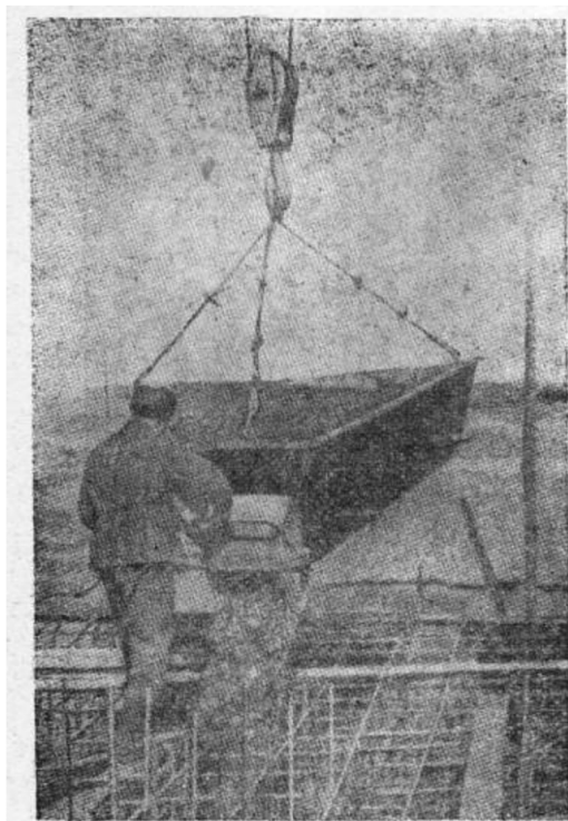
圖 4 用震動料罐向結構中輸送和澆灌混凝土
