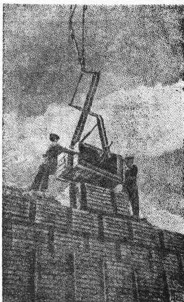
圖 7 安裝大型磚砌塊的牆
