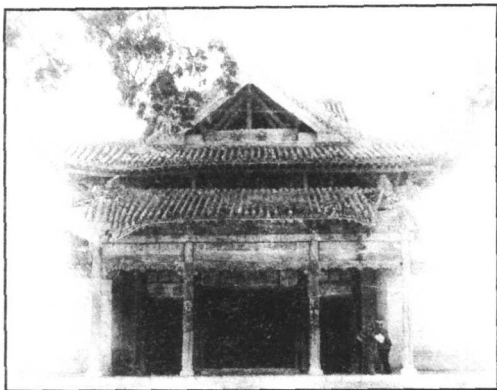
山西临汾东羊村 东岳庙元代戏台
