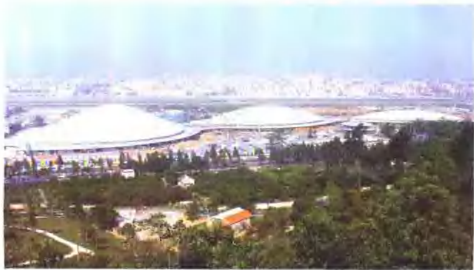
中油吉林化建特种结构工程有限责任公司承建的广州体育馆工程
