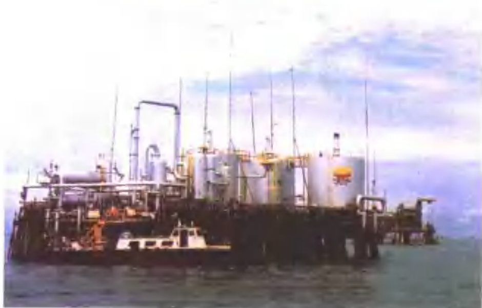
中委公司管理的两个油田产量不断提高。图为位于南美洲第一大湖——马拉开波湖上的英特甘博油田 20 号转油站（王毅楷 摄）
