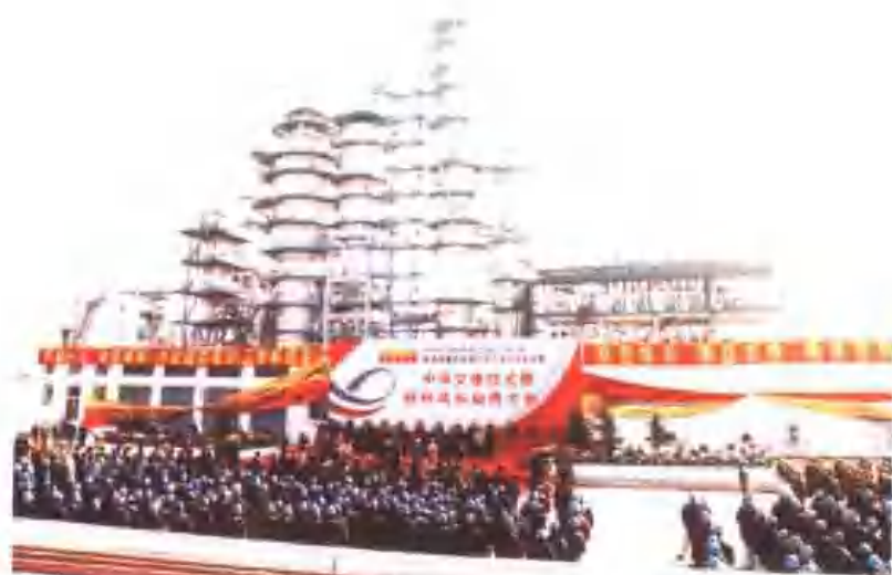
抚顺石化分公司在优化生产布局、资源配置和产品结构方面实施了重大动作。2001年，其重油接触裂解制乙烯工业化试验装置开工顺利 (崔波 摄)
