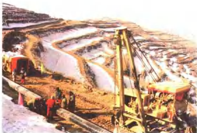
兰成渝管线是兰州—成都—重庆的多品种输油管道。2001年，这条管线的兰州—成都段已全线贯通，成都—重庆段正在加紧施工
