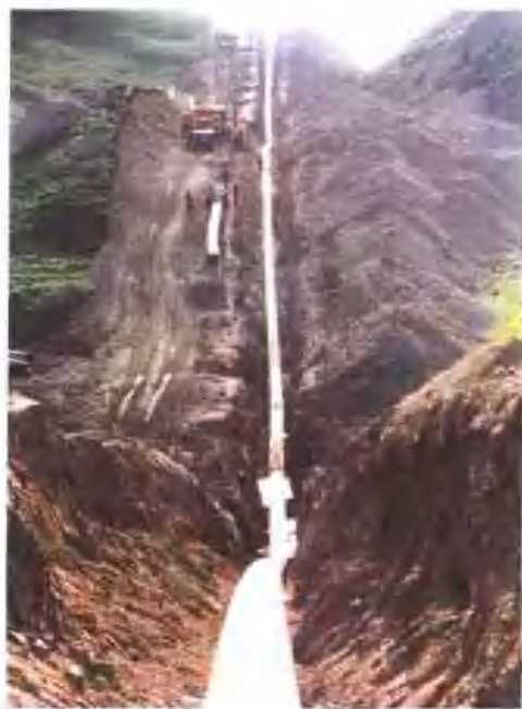
2001年，涩宁兰输气管道工程竣工投产。图为涩宁兰管线在全线最高点——海拔3840米的拉鸡山施工时的情景
