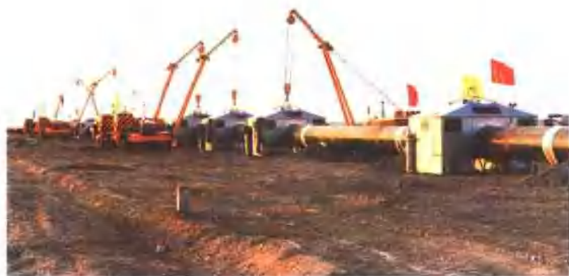
西气东输工程程序规范，管理科学，基础扎实。图为其试验段上的全自动焊机组（杨志明 摄）
