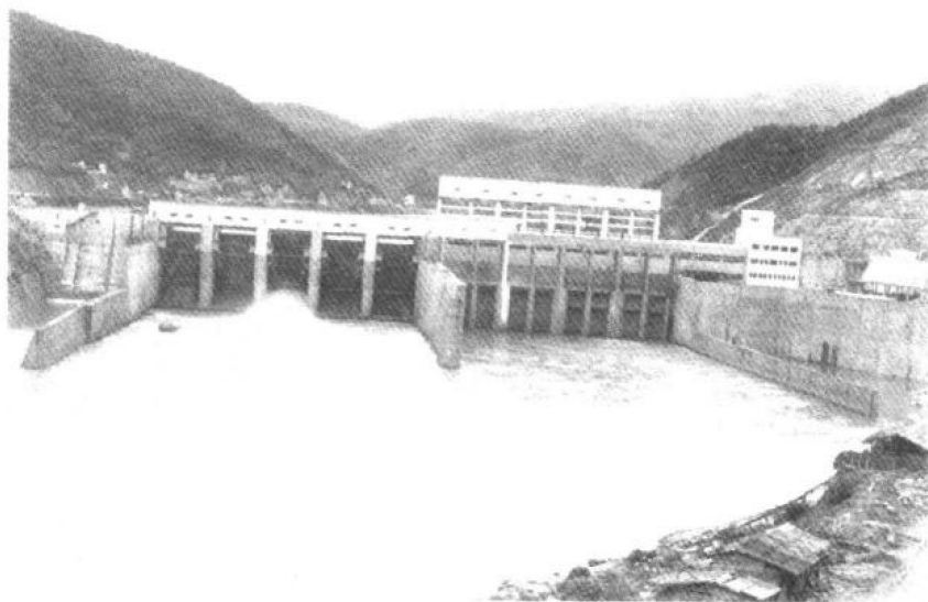
图 1-3 青溪重力坝（广东，坝高 51.5m，混凝土 14 万 \text{m}^3 ）
