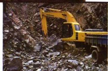
岩石工况现场
