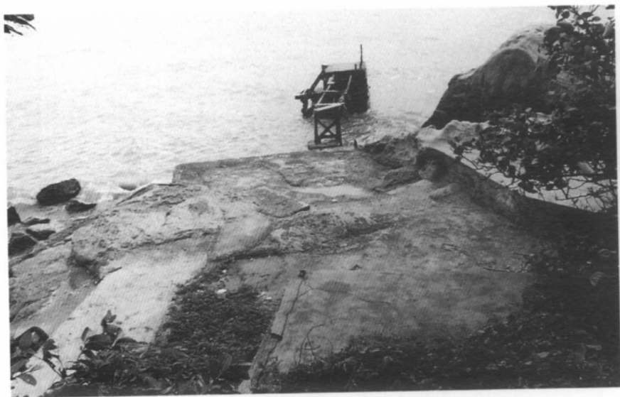
位於摩星嶺山腳的一處探射燈台
