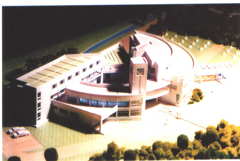
10 杭州联合国小水电站中心
