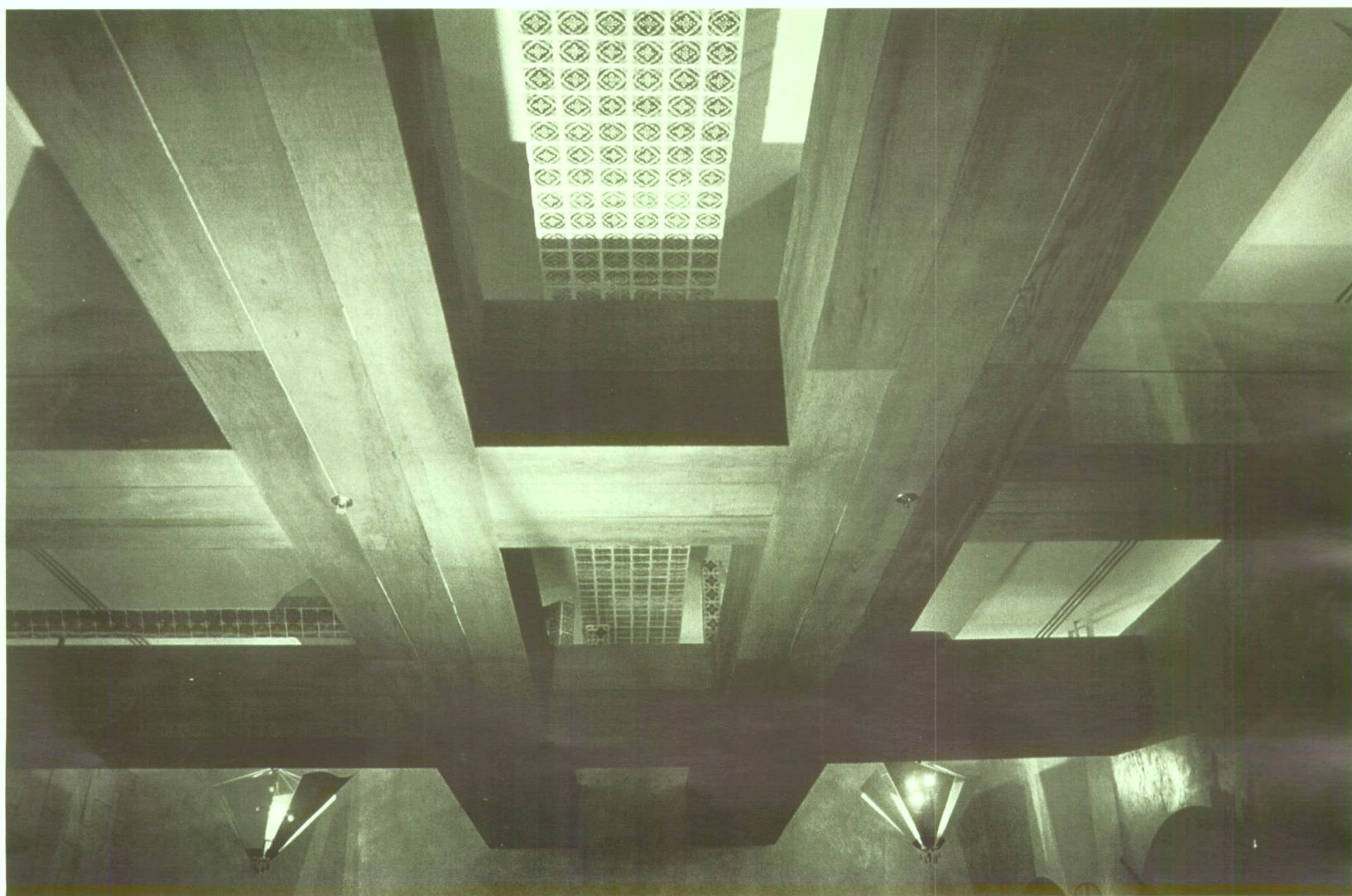
餐厅剖面图。空调管道藏于巨大的木梁之中。
