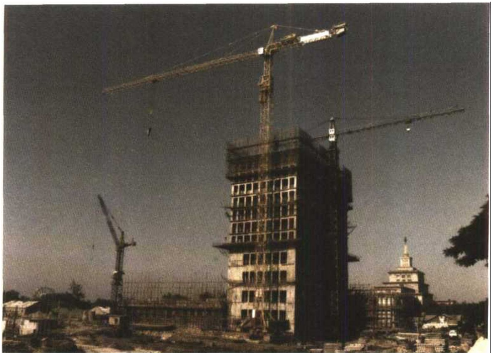
· 建设中的彩电中心。
