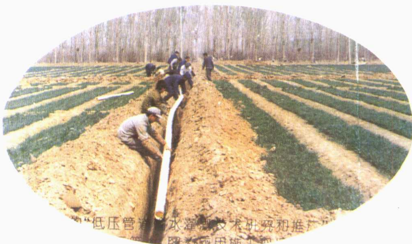
低压管道喷水灌溉，图为施工现场
