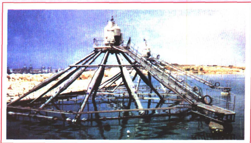
彩图6 欧洲的全自动海水网箱（在遇到恶劣天气时可沉入水中）
