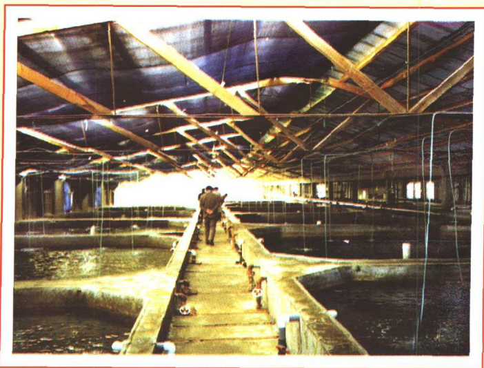
彩图3 牙鲈养殖车间构造（示屋顶和拱形梁）
