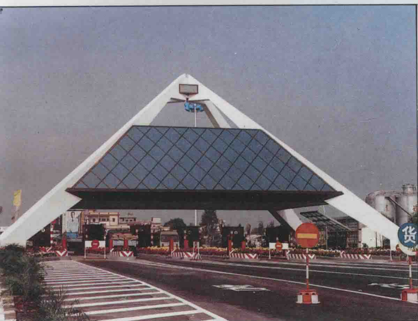
福建厦门海峡大桥(收费站)
