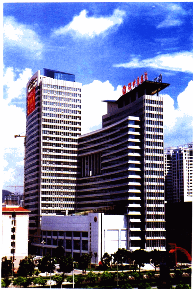
1999年6月竣工并投入使用的深圳商报社大厦
