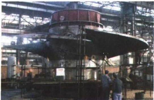
2. 葛洲坝电厂的水轮机转轮在工厂装配。
