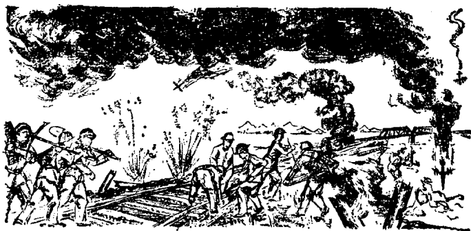
图1 抢修铁路的紧张场面
