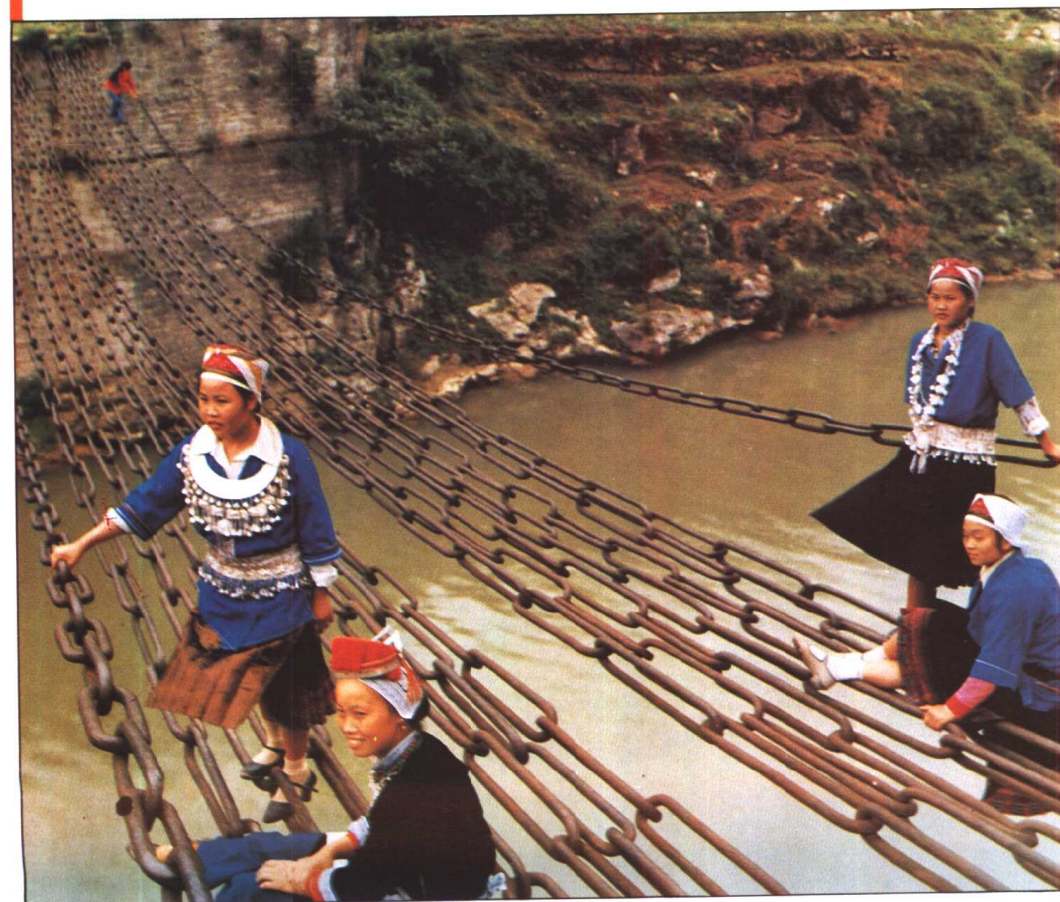
重安江铁索桥
