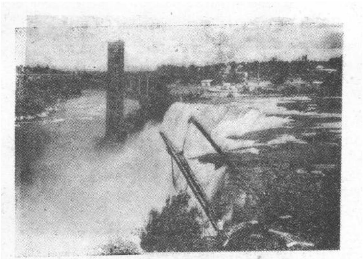
图 1.4 尼亚加拉瀑布。坚硬的奥陶纪石灰岩覆盖在较软的石灰岩和页岩上面；瀑布已向其上游退缩，形成峡谷（向左边看）。正在打倾斜的钻孔，确定前缘岩石的不稳定程度，以便抢救
