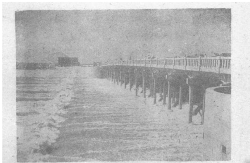
图 9-4. 某河分洪閘閘下泄流。
