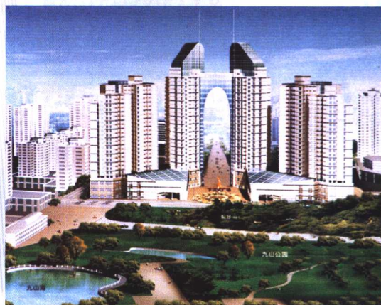
公司开发的“新国光商住广场”正在建设中
