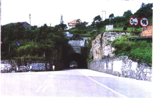
仙清线赤岩隧道
