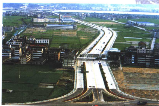
东瓯大桥接线工程
