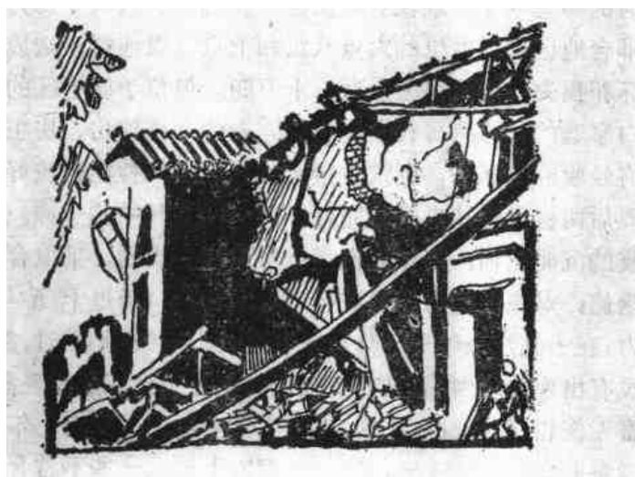
图 1—5 峨山县医院门诊楼倒塌
