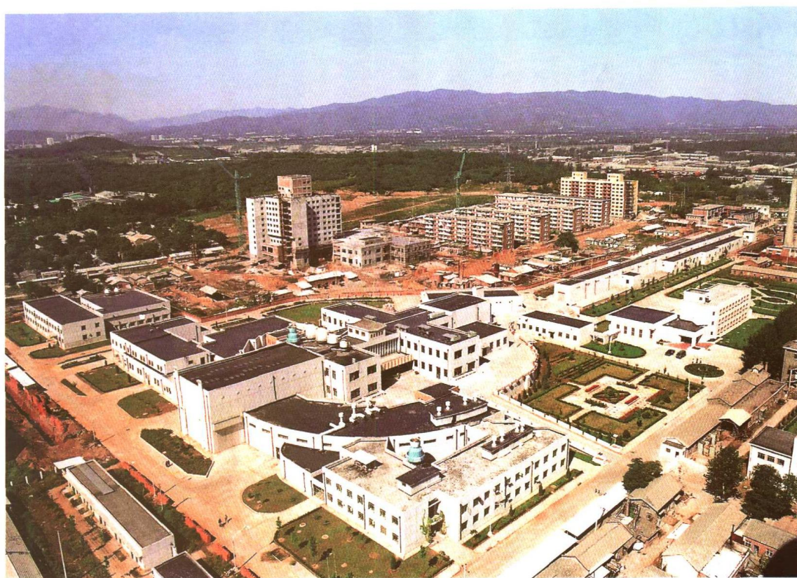
北京正负电子对撞机鸟瞰。正负电子由直线加速器（照片右上方）区加速至分叉区进入储存环。北京谱仪位于储存环南端（左下方）对撞点处。沿环东西侧切线方向为同步辐射区
